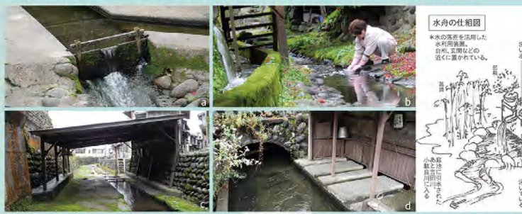
a. せぎ板で用水路の水をせき止めたところ。 b. せぎ板で水位を上げて洗い物をする。 c. 共同カワド。地域のコミュニティの場でもある。 d. 郡上八幡のカワドや水舟は今でも現役で使用されている。使われることが文化の継承に最も優れている。 ※郡上八幡の水事情については下記書物に詳しい。 「水の恵みを受けるまちづくり(読部一二巻 鹿島出版会)」「水縁空間 住まい学大系/055(読部一二巻著 住まいの図書館出版局)」
